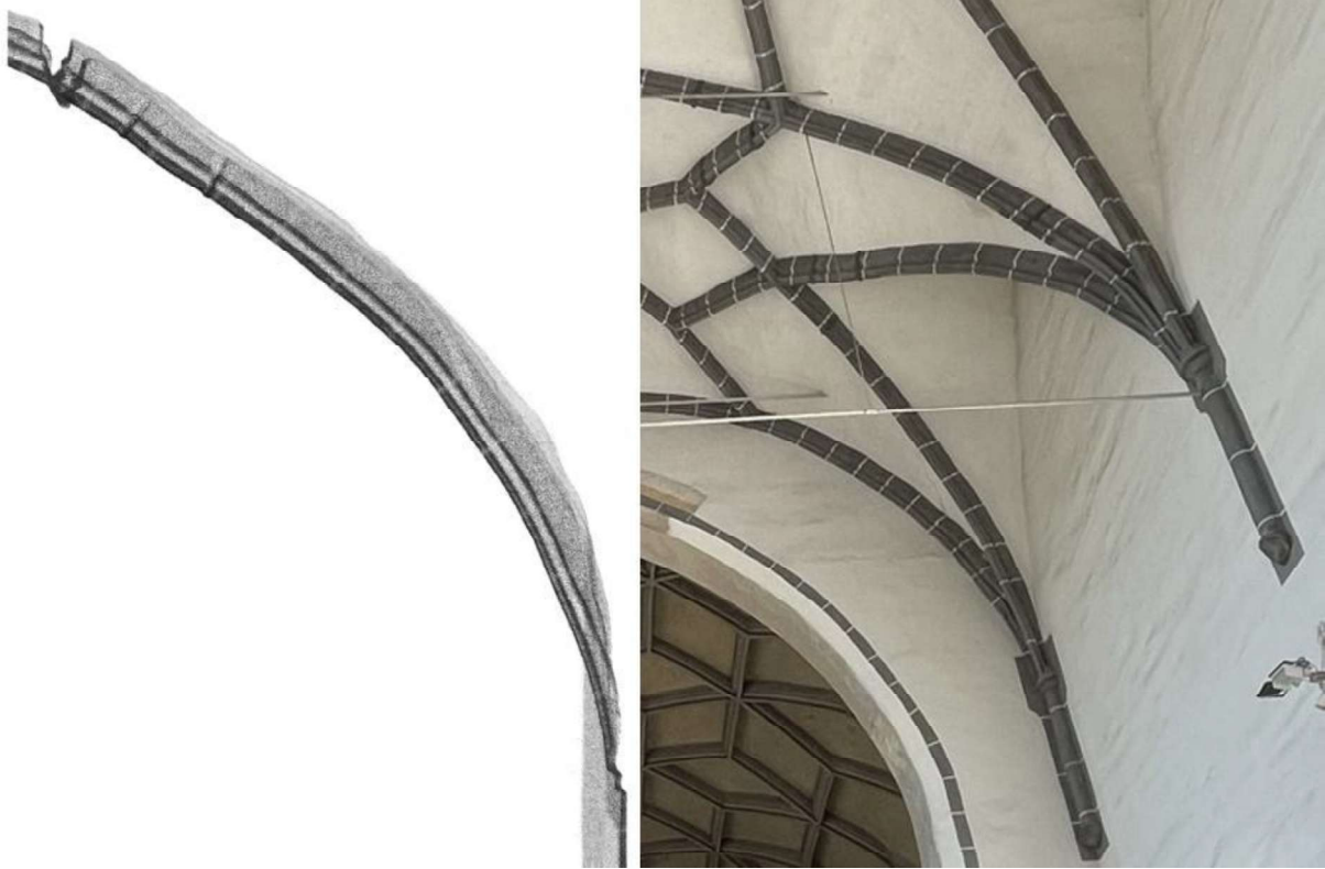
5-15. ábra Töréspontok adott bordán belül a szeged-alsóvárosi szentélyboltozatban
